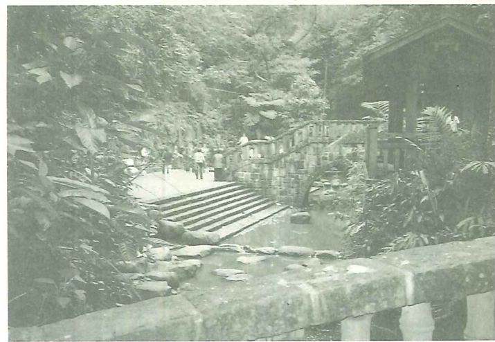
鎮公所承辦大屯溪北勢橋下溪堤工程的汪精良先生與承包商張先生謹慎從事，在施工前特地带領師大汪靜明教授與籌備會執行秘書李永志老師前往台北市虎山溪自然步道參觀——這是張先生先前承包的工程，頗有天人合一的境界，也是生態保育追求的目標。（李永志攝）
