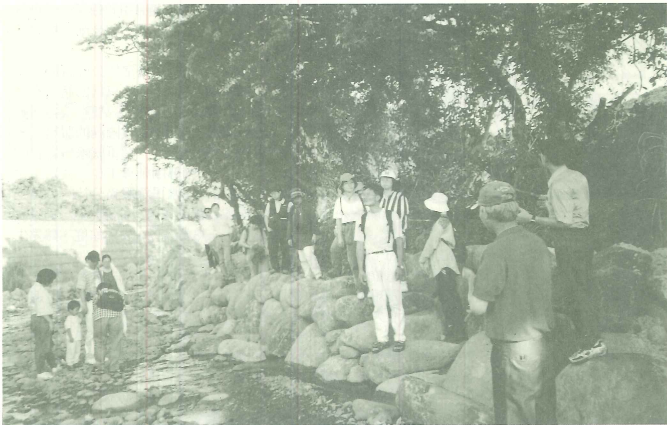
台北縣河川生態保育協會籌備會召集人陳天送先生與莊棋凱委員向關心的朋友們解釋自然工法：照片中左邊先前完工的水泥堤岸完全阻隔了親水性，也未顧及景觀性與生態性，而現在正施工的右邊，則因公所與學者專家、當地里民合作，而大幅改善，並保留了先人所築石堤與茄苳植物（本照片攝於淡水鎮中和里北勢橋下方一百公尺處）。（李永志攝）
